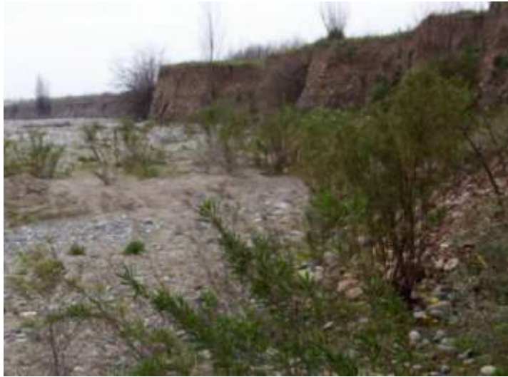
Foto 3: Riberas socavadas por crecidas del río Cachapoal en el sector de El Almendral.
